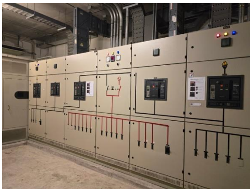
รูปที่ 2-38 ตู้ควบคุมระบบไฟฟ้าหลัก
