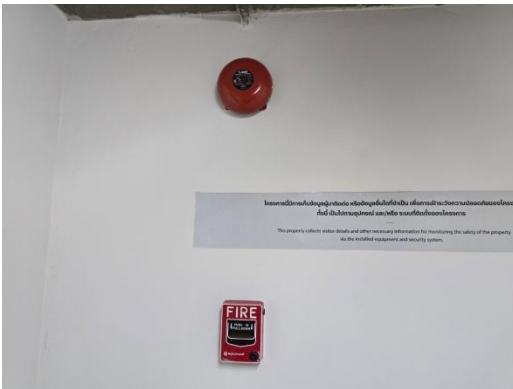
รูปที่ 2-19 อุปกรณ์แจ้งเหตุเพลิงไหม้
